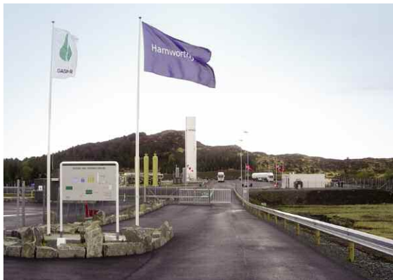
Snurrevarden LNG plant, Norway.
